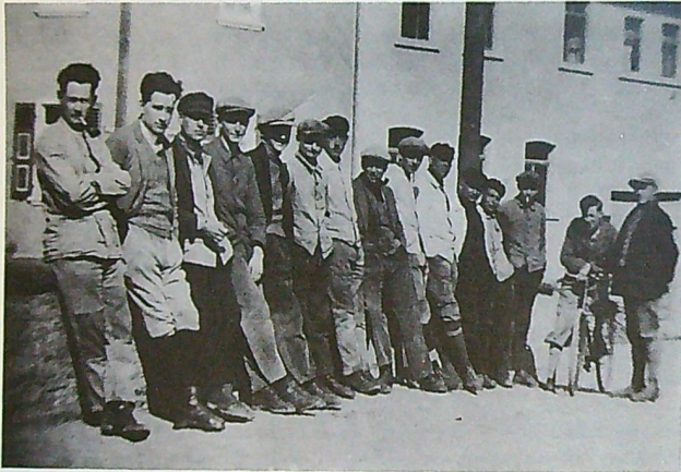
Auf der Brücke in den 30 er Jahren:
