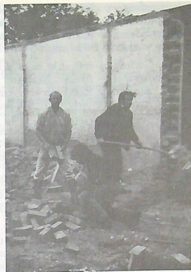
Ortsbrandmeister Hoffmann mit einigen Mitglieder bei den Abbrucharbeiten.
