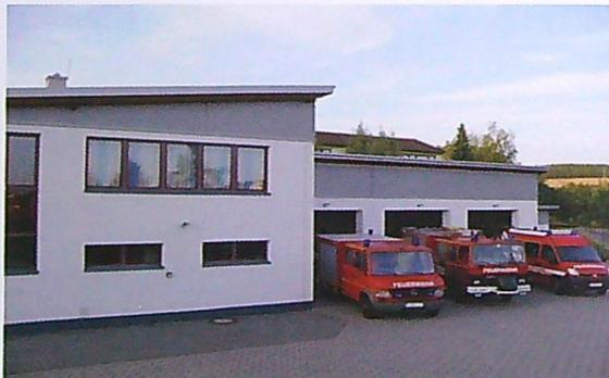
Mauerwerk erstellt. In diesem sind rund 300 m<sup>3</sup> Beton und Stahlbeton und ca. zwölf Tonnen Betonstahl eingebaut worden. Als nächste Arbeit stand der Einbau der Fenster an. Danach folgten Innenputzarbeiten und die Durchführung der Installationsarbeiten, alles in Eigenleistung.
