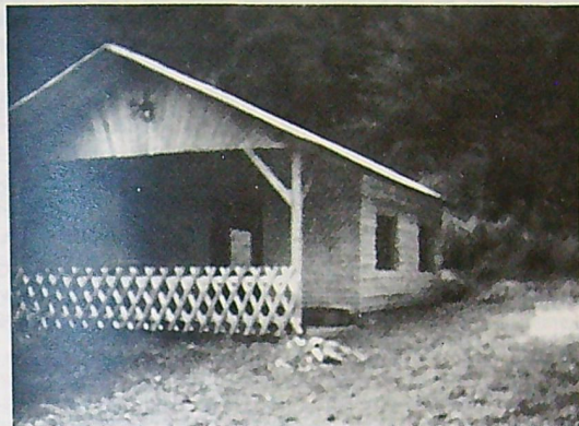
Die von der Freiwilligen Feuerwehr erbaute Schutzhütte im Heiligenwald 1971
